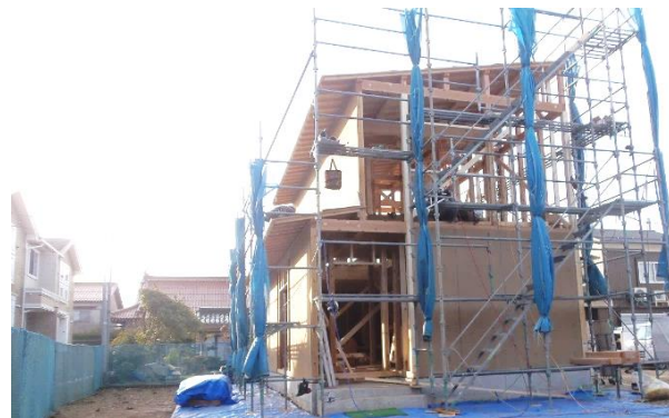
外周にはパネルを打ち込み強固な建物へ
