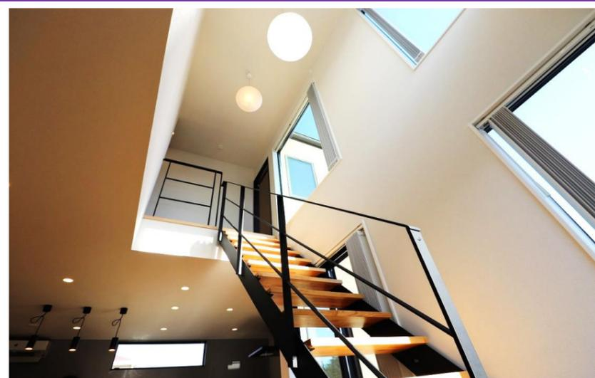
開放的なスチール階段を設置されました。室内に差し込む自然の光や照明を遮らないので、全体が明るく、また1階フロアをより広く見せる効果があります。階段と2階フロアを遮る壁もないので、家族間のコミュニケーションもアップしますね。
