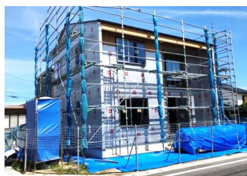
パネルの上から防水シートを貼り、水の侵入を防ぎます
