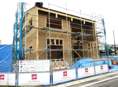
外周には断熱材付のパネルを打ち込み、より強固な建物にしていきます
