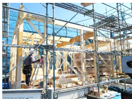
起こしながら垂直を固めていきます
