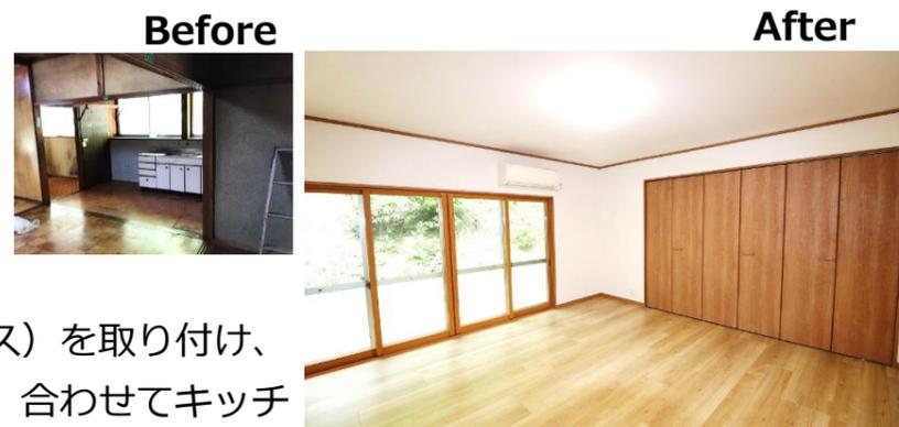
現在の窓に内窓（インプラス）を取り付け、お部屋の熱を出さない工夫を。合わせてキッチンの取替えをして収納力をアップしました。
